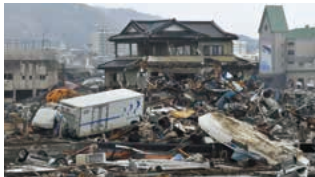
東日本大震災津波により漁船や大型トラックなども内陸まで流されました
