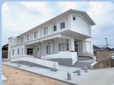
長島地区放射線防護対策施設
