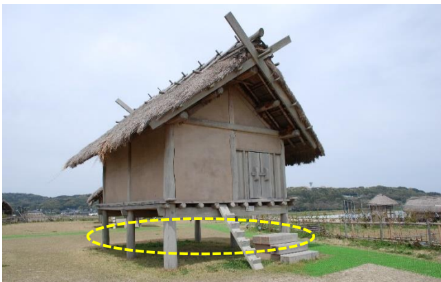
主祭殿 支柱6本地上部分防腐処理
