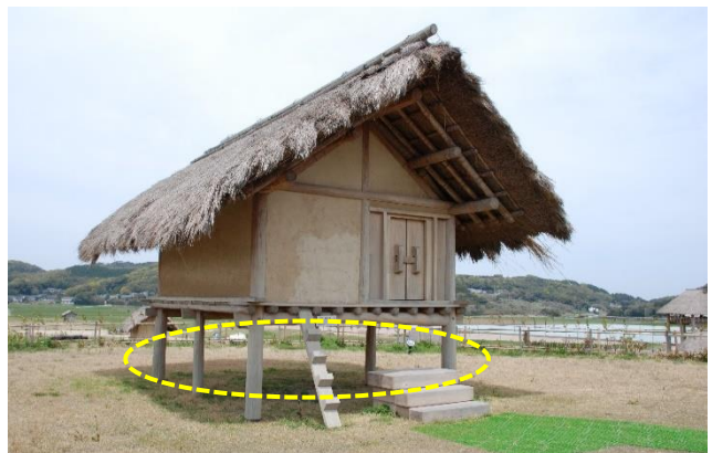
食祭器倉庫 支柱6本地上部分防腐処理
