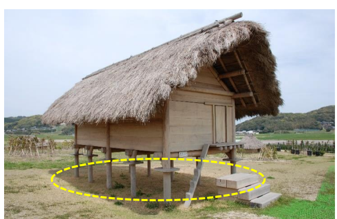
穀倉 支柱10本地上部分防腐処理
