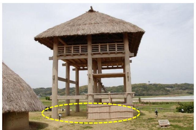
物見櫓 支柱9本地上部分防腐処理
