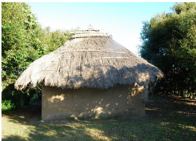
平屋脇殿 側壁全面の土壁改修（外面全面）
