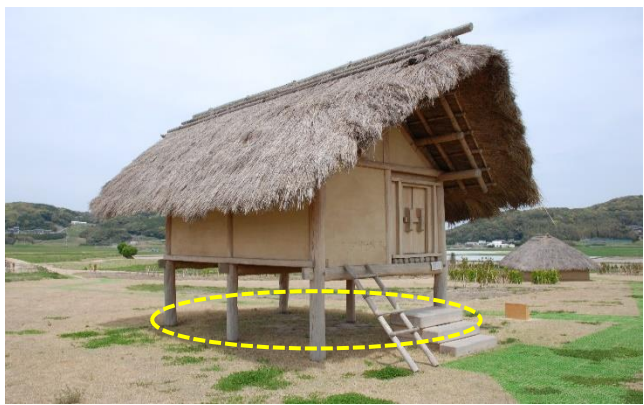
交易倉庫 支柱6本地上部分防腐処理
