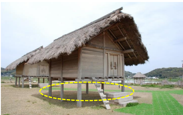
祭器倉庫 支柱6本地上部分防腐処理
