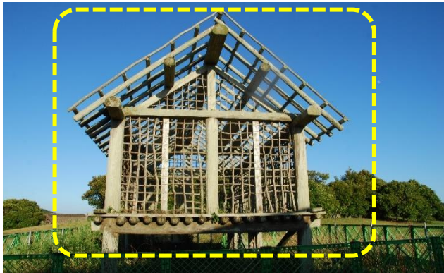
使節団倉庫 全面防腐処理及び補修
