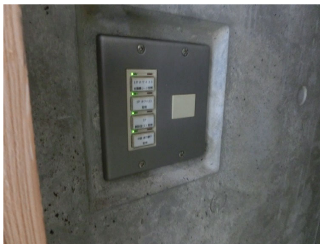
大ホール棟 1 階 自販機置き場入口
