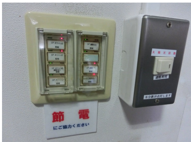
中ホール棟 1 階 101 会議室前階段
