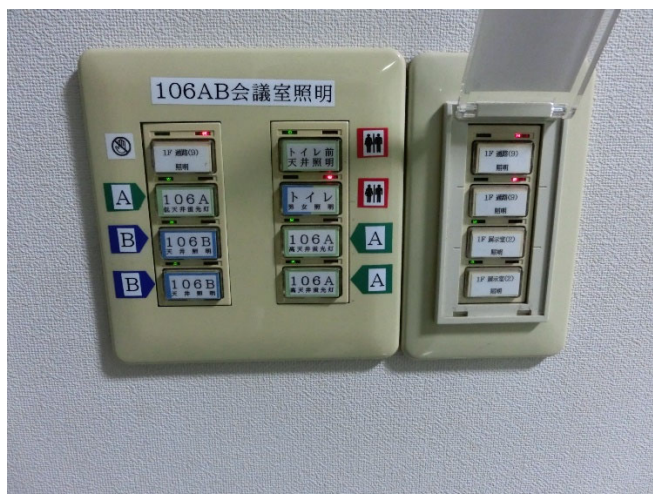
中ホール棟 1 階 106 会議室入口
