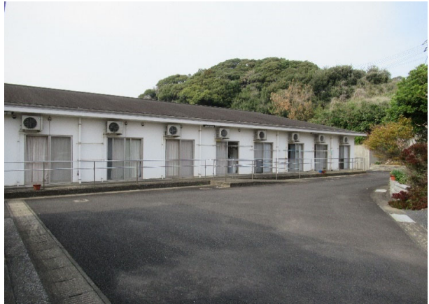
外観 新棟 駐車場側
