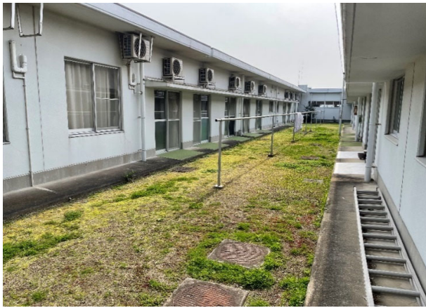
外観 2棟・3棟 山側
