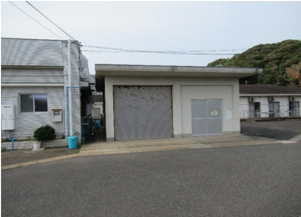
外観 車庫・リサイクルステーション
