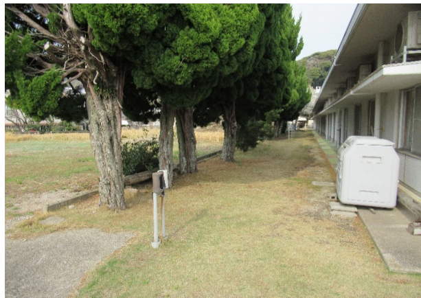
外観 3棟・広場 海側
