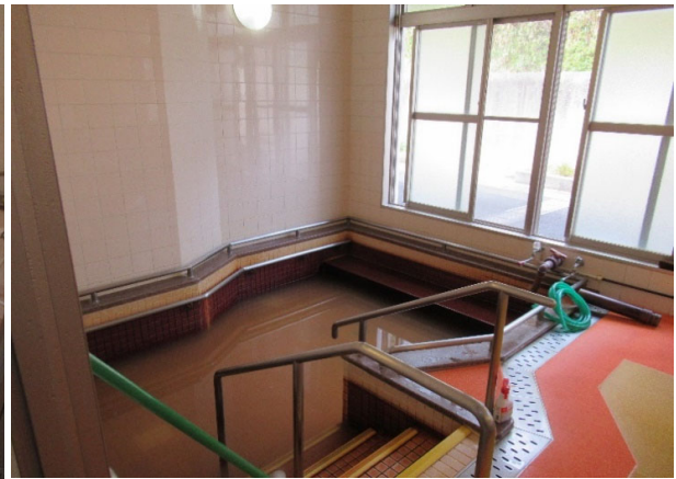
新棟 浴室（女性）
