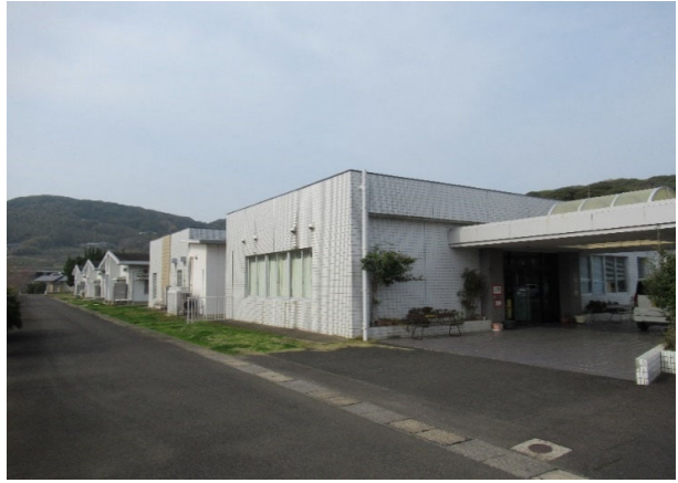
外観 正面玄関 海側
