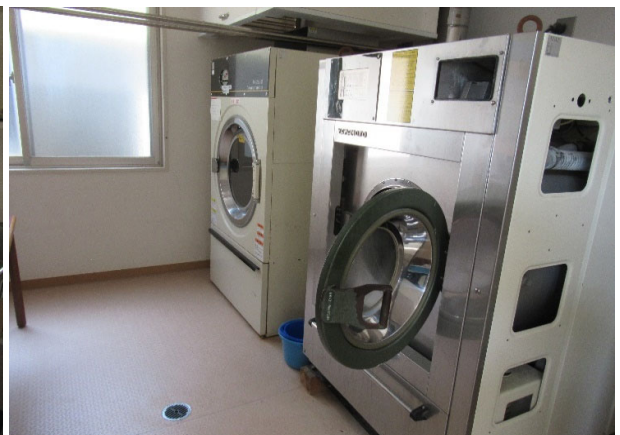
新棟 リネン室
