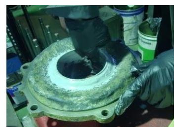
ポンプの穴開き補修
