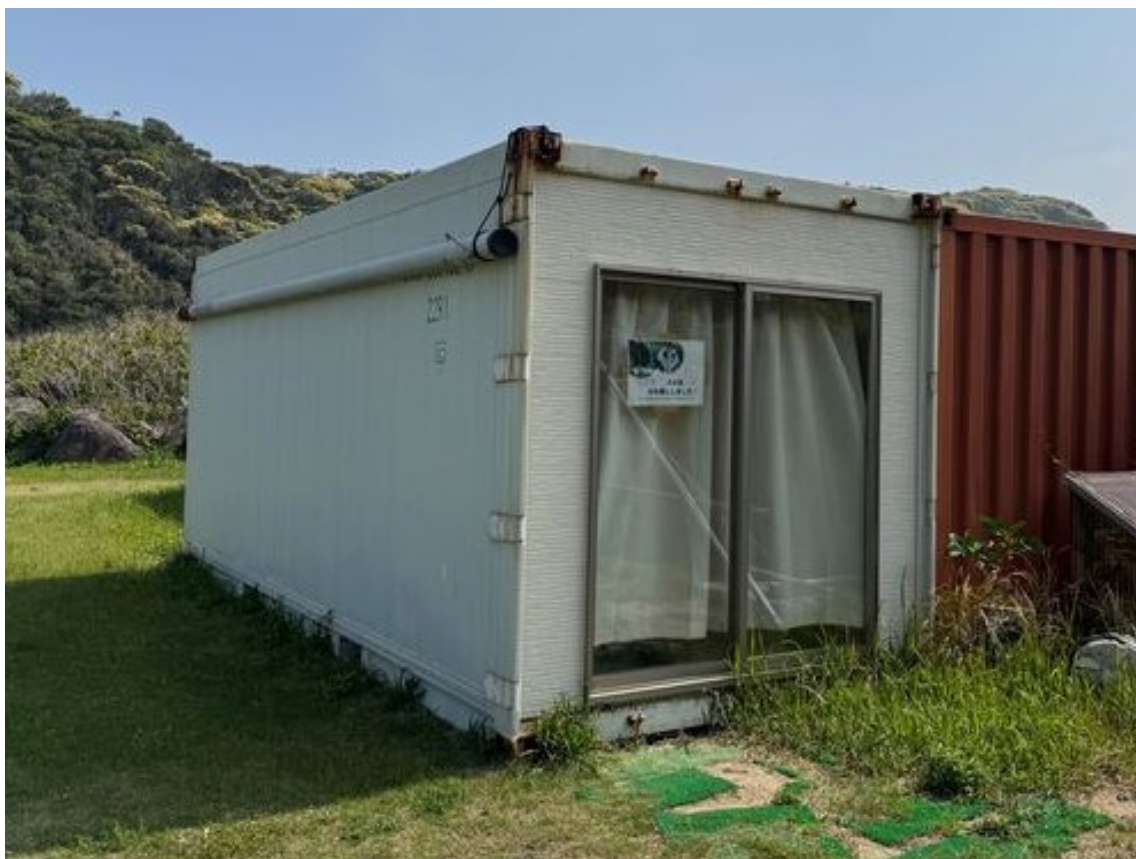
②-13：仮設コンテナ倉庫(白)①
