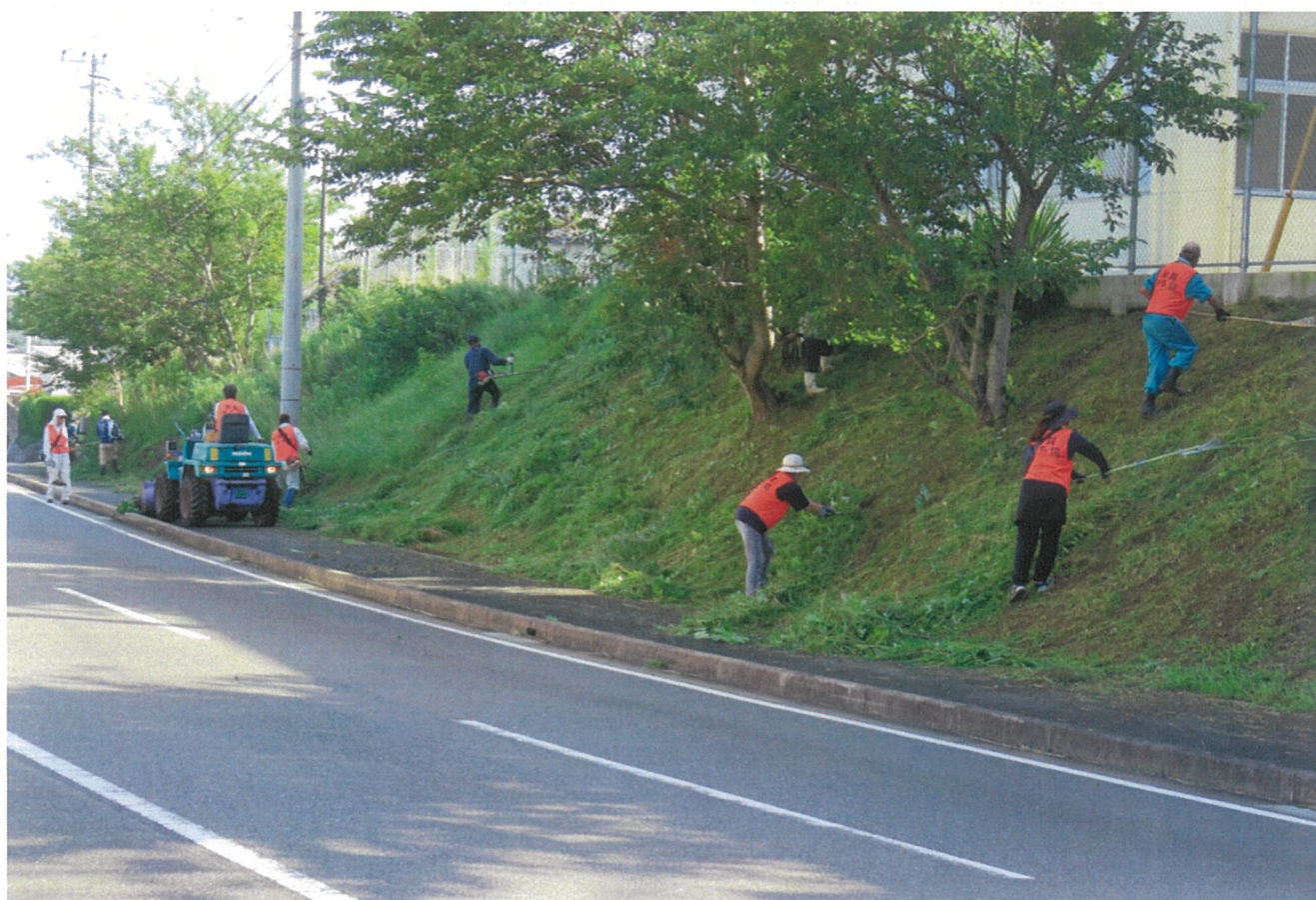
写真 芦辺中学校 法面
