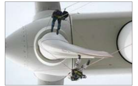
上) 風車ブレードの修理。維持管理は、現場で行われる作業も多い。
