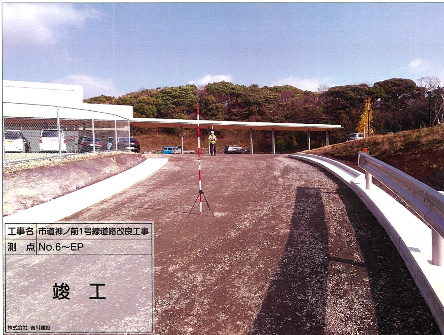
竣工 No. 6~EP (No. 6+15)
