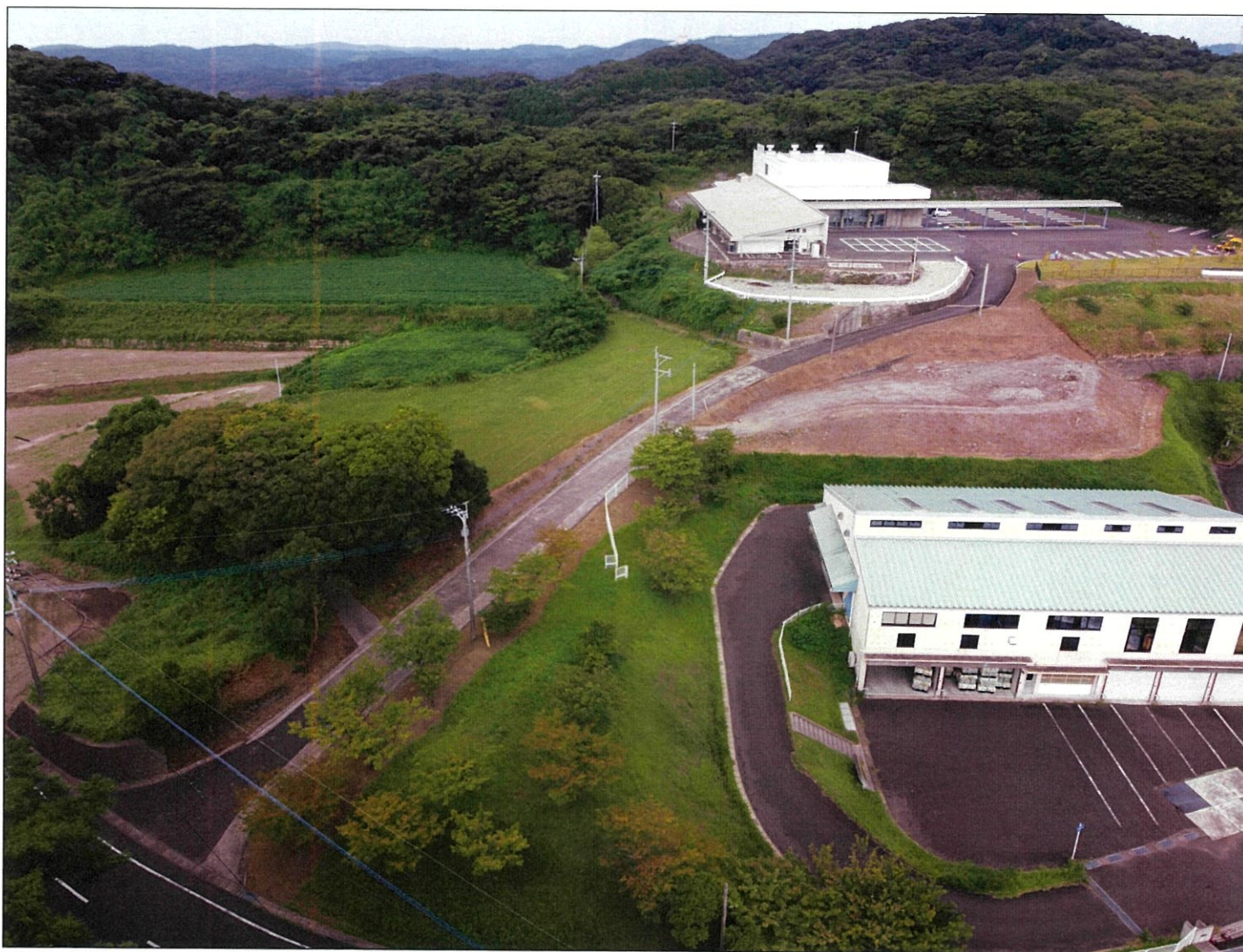
着工前 No.0~EP (No.6+15) 全景
