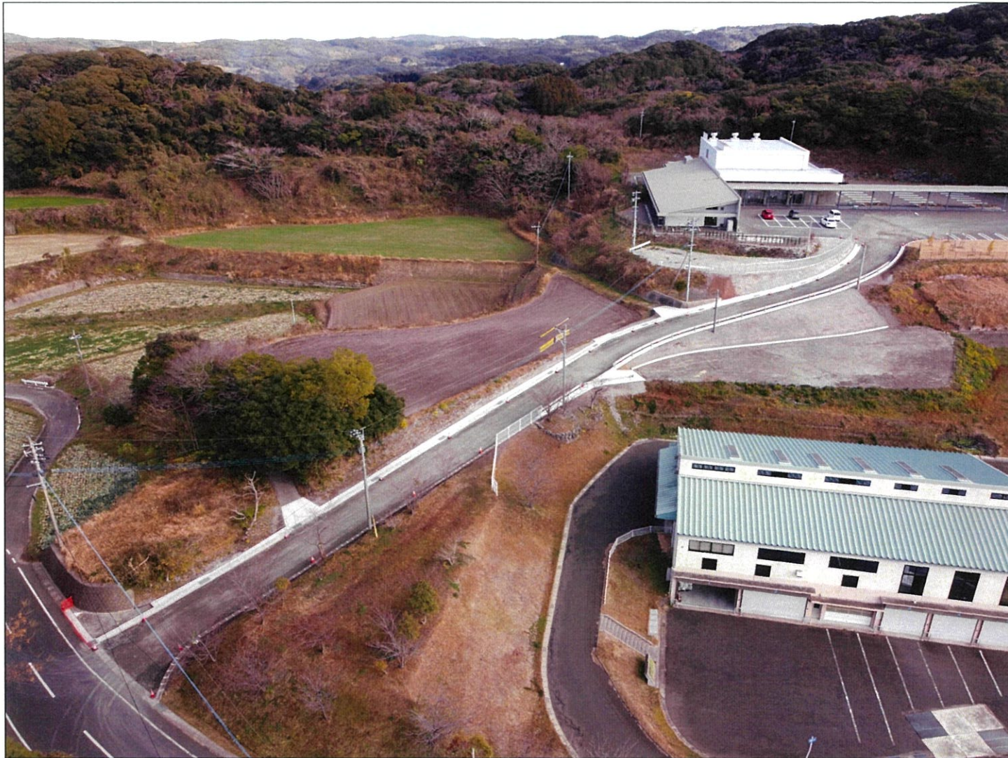
竣工 No. 0~EP (No. 6+15) 全景
