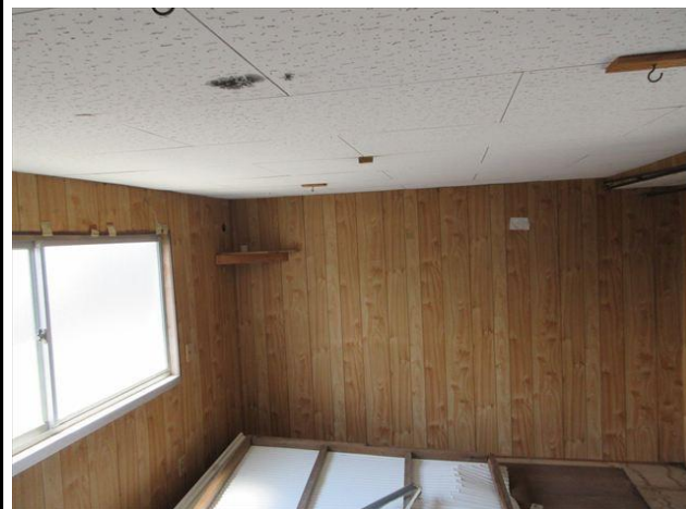
36号室-洋室(増築部分)
