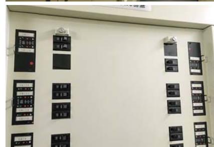
壱岐の島ホール大ホール調光盤設備改修工事
