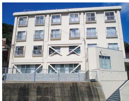
久喜団地耐震改修事業
