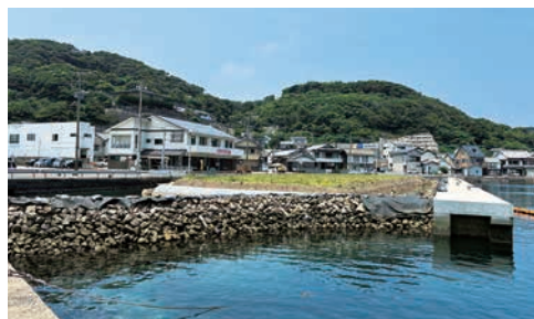
勝本港埋立地
