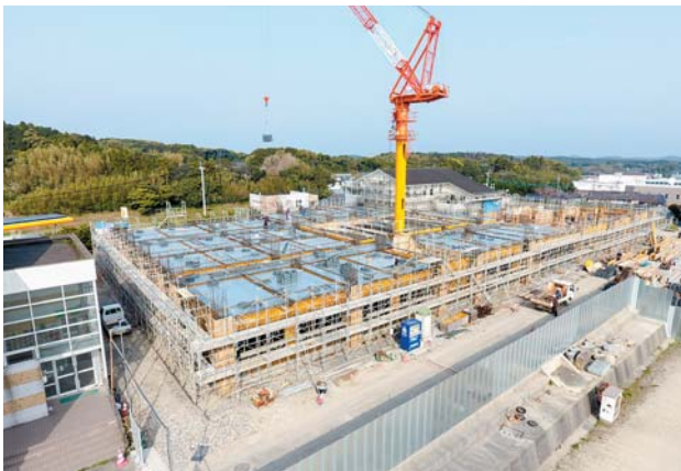
新芦辺中学校建設現場
