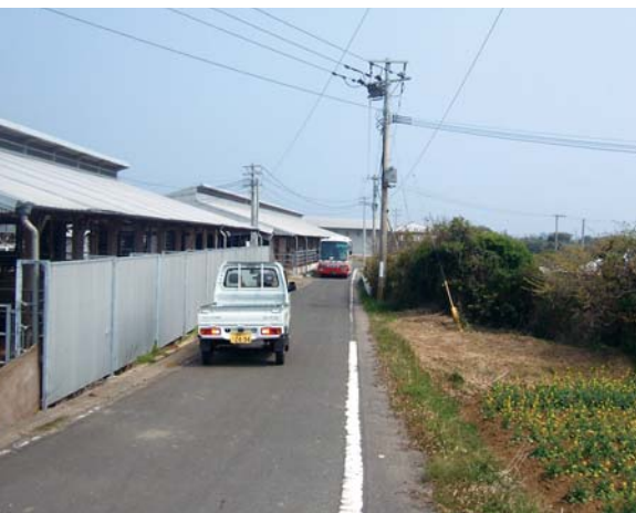
車の離合が困難な市道江角諸津線
