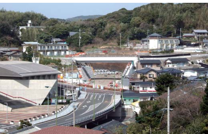
建設が進む新郷ノ浦港線(吉岐文化ホール付近)
