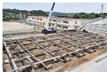
建設中の芦辺小学校体育館
