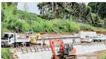
復旧工事が進む市道西谷仲田線 (勝本町片山触)
