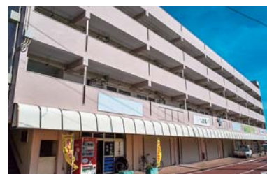
耐震改修工事等をおこなった目坂団地(石田町)
