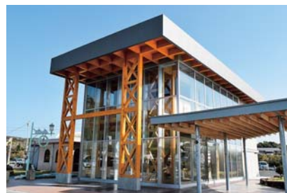
完成した吉岐観光サービス拠点施設
