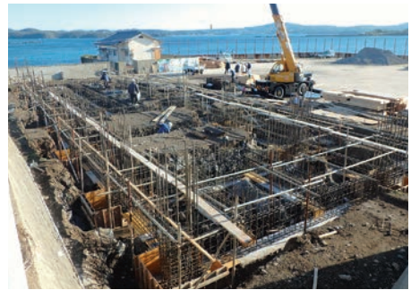
建設中の長島地区放射線防護対策施設
