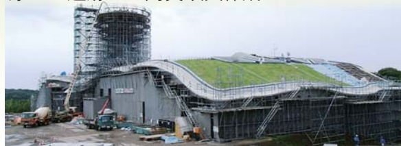
建設が進む一支国博物館(芦辺町鶴亀触)
