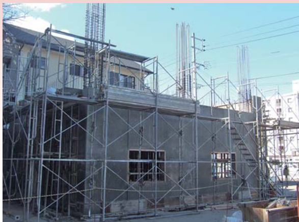
新築工事中の郷ノ浦地区機動分団消防格納庫 (JA武生水支所横)
