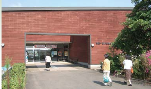
ガイダンス施設として生まれ変わる現原の辻展示館
