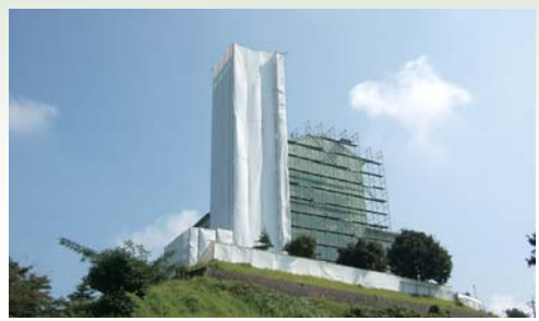
解体工事中の芦辺町クリーンセンター
