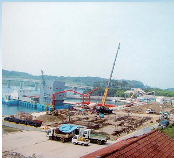
建設中の沓岐地域栽培漁業センター（郷ノ浦町大島）
