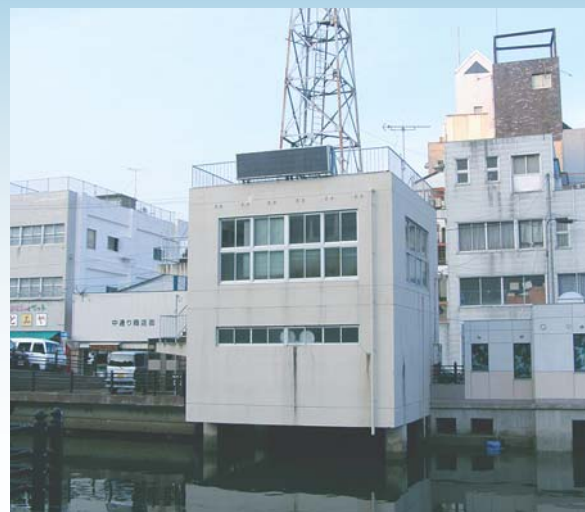
建て替え予定の消防格納庫 （郷ノ浦地区機動分団）
