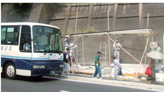
上屋根工事中の団地入口バス停 (郷ノ浦町東触)
