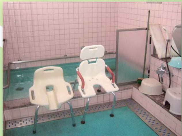
改修予定の浴室 (芦辺町デイサービスセンター)
