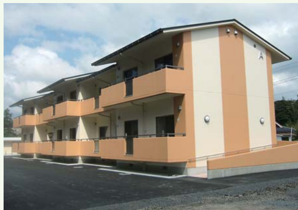
新築された白水団地（石田町石田西触）
