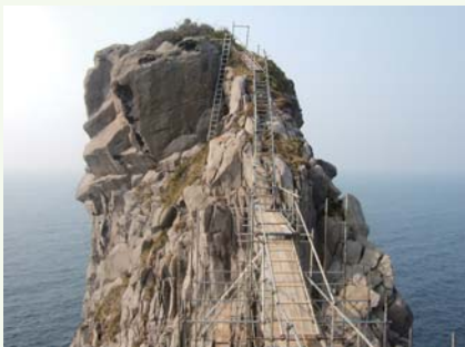
修復工事が施されている猿岩
