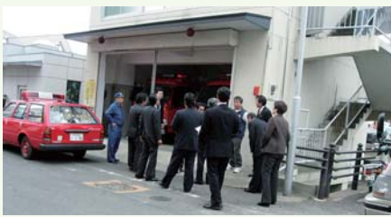
老朽化の著しい消防格納庫(郷ノ浦地区機動分団第1・第2小隊)
