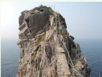
修復工事が施されている猿岩
