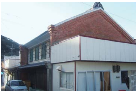
勝本浦の街なみ (旧松本薬局のレンガ壁)
