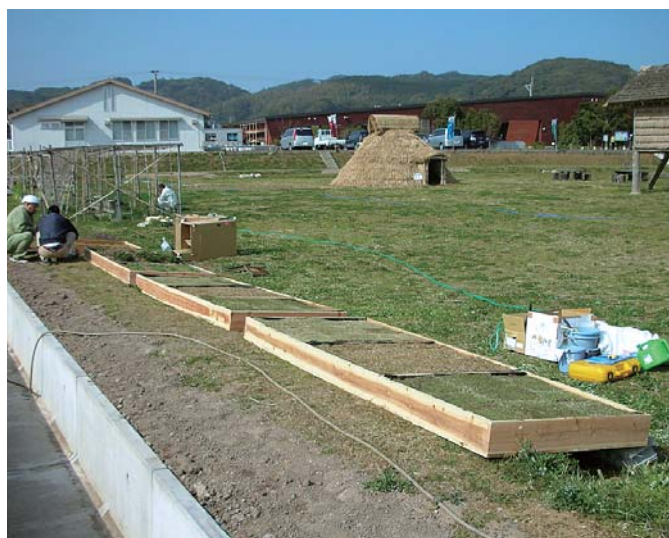
屋上緑化の植栽実験開始 (H19.3.23 原の辻展示館前)
