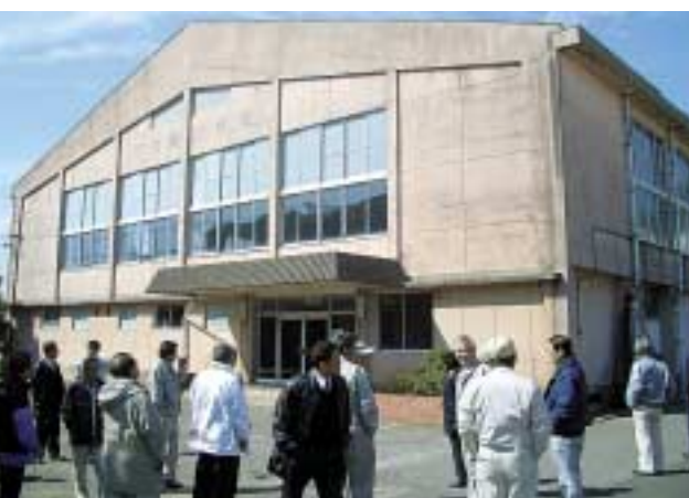
解体される予定の石田町体育館
