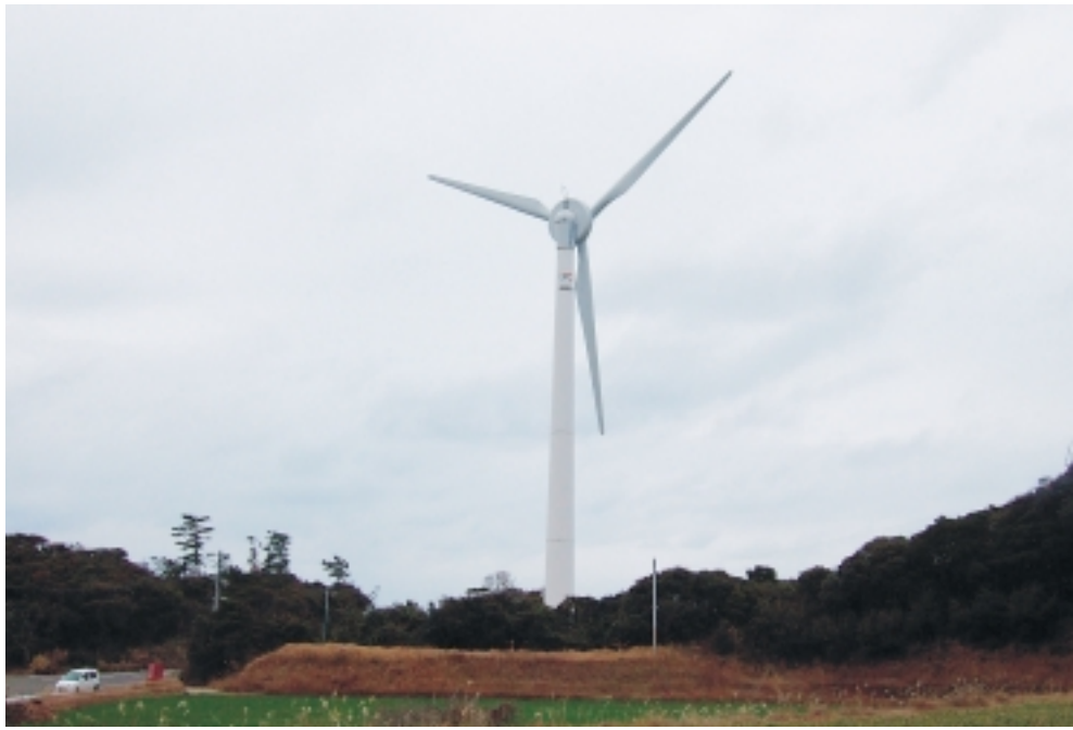
風力発電所（芦辺町箱崎諸津触）
