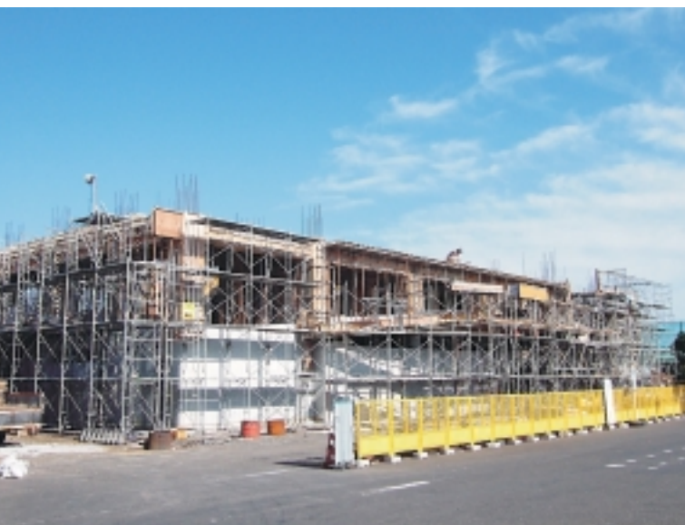
建設中の芦辺港ターミナルビル
