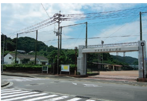
芦辺中学校建設予定地
