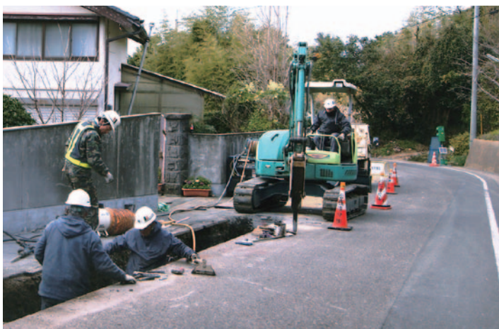
施工中の公共下水道工事
