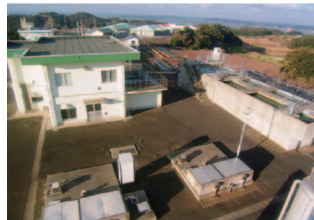
簡易水道・門野田浄水場(郷ノ浦町)
