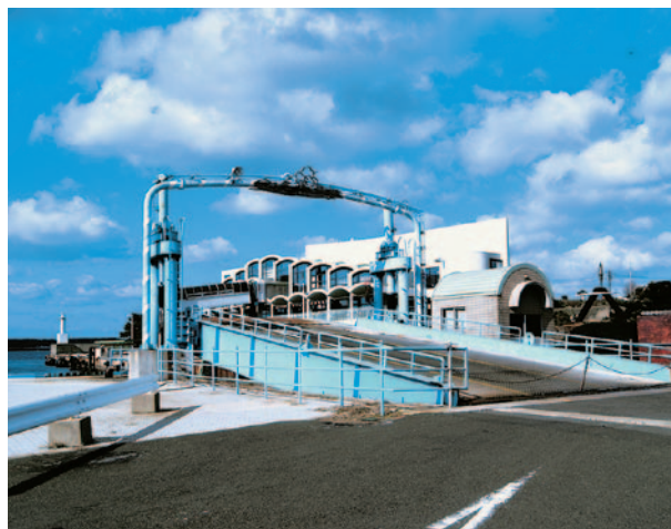
郷ノ浦港の航送船可動橋
