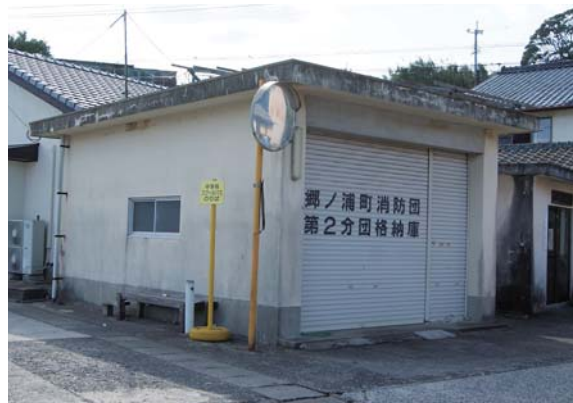
建替えられる渡良浦の消防倉庫
