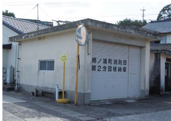
建替えられる渡良浦の消防倉庫
