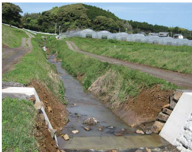
本年度の「町谷川」河川改修工事箇所
