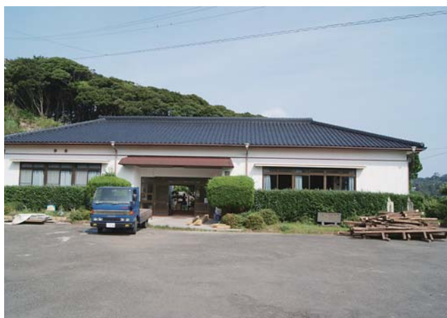
大規模改修の始まった勝本町東触公民館
