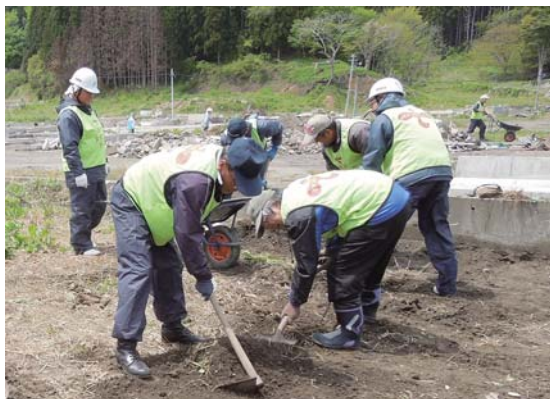
釜石市での農地瓦礫撤去(老岐土地改良区の皆さん)
