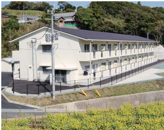
市営住宅 桜木団地（芦辺町瀬戸浦）
