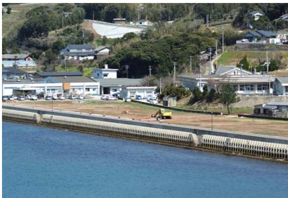
現 特別養護老人ホームと養護老人ホーム前の建設候補地
