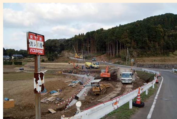
工事中の県道湯ノ本芦辺線
