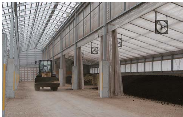
平成22年完成の堆肥センター(郷ノ浦町)
