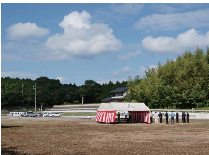
給食センターの本体建設工事が始まります。(勝本町亀石)
