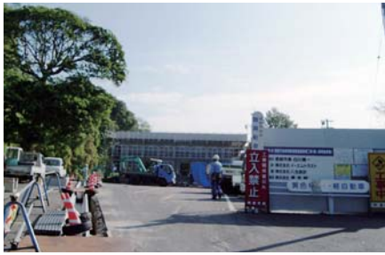
完成間近のケーブルテレビ放送センター (郷ノ浦町亀丘)
