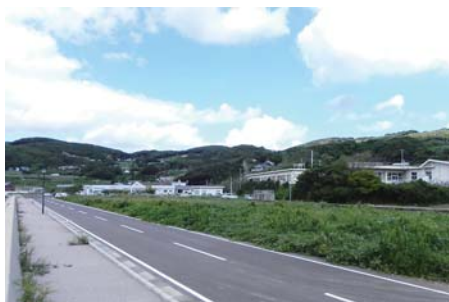
特別養護老人ホーム新建設予定地(現・特養老人ホームの下)
