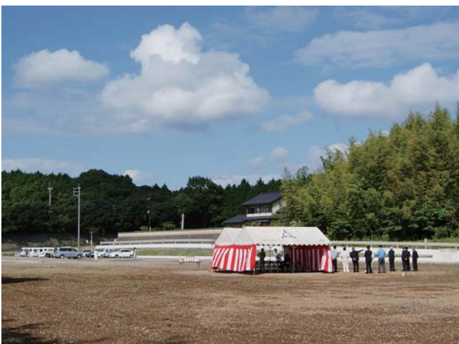
給食センターの本体建設工事が始まります。(勝本町亀石)
