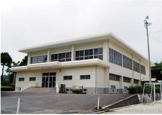
雨漏り修理の終わった志原小学校体育館
