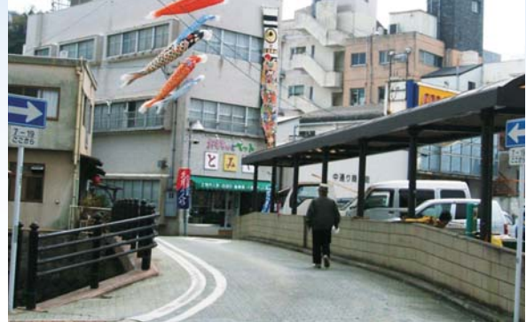
補修を急がれる中央橋
