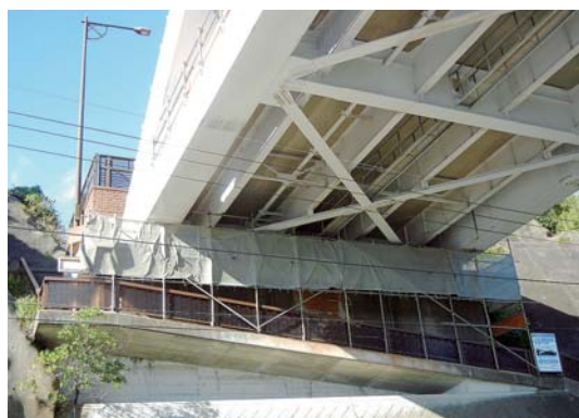
郷ノ浦大橋修復工事
