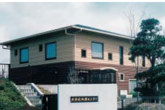
北部水処理センター
