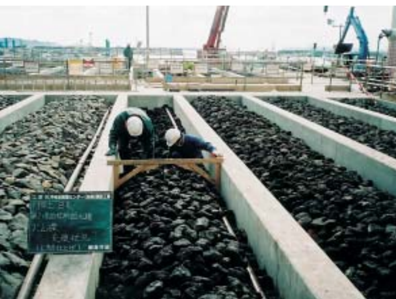
火山れき充填状況（中央水処理センターにて）
