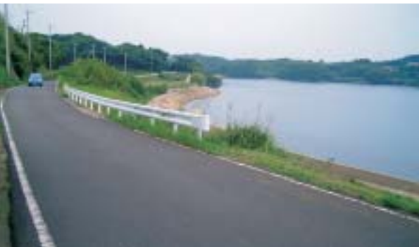
県道59号線（勝本町立石西触付近）
